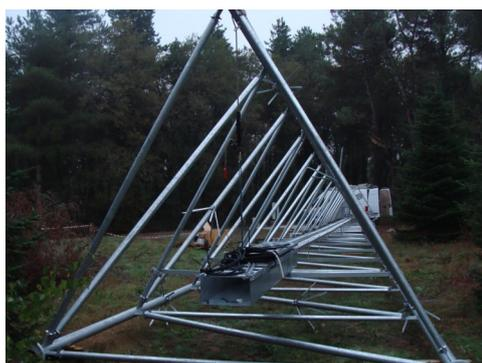
Le pylône prémonté au sol.
